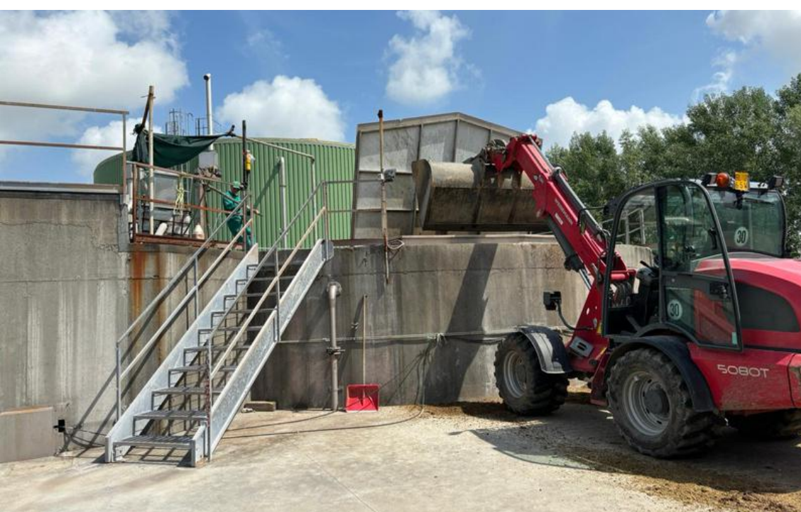
L'alimentazione dell'impianto a biogas
